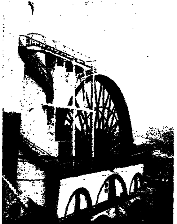
In Laxey steht das größte Wasserrad der Welt. Es hat einen Durchmesser von 22 Metern und ist 151 Jahre alt.
